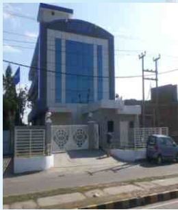
HORIBA, HARIDWAR (TURNKEY PROJECT)
